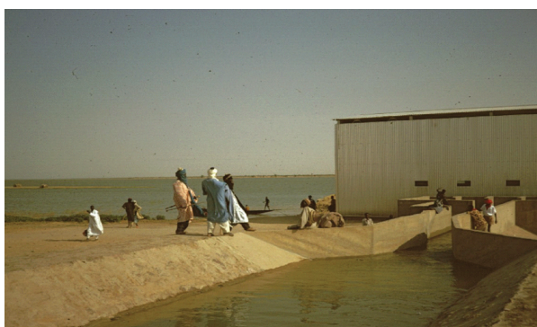
Inauguration de la centrale de Diré (1979).
